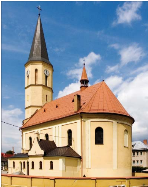
Kościół p.w. św. Anny w Krzyżanowicach – zbudowany l. 1791-1793
