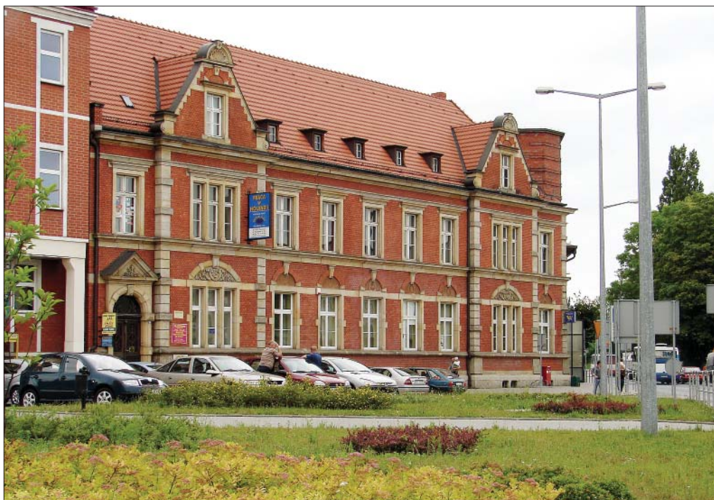
Racibórz. Budynek Poczty Polskiej, dawna poczta cesarska oddana do użytku w 1889 r.
