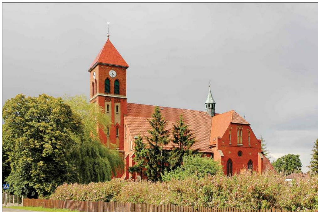
Kościół p.w. Narodzenia Najświętszej Maryi Panny w Łubowicach (gmina Rudnik) – zbudowany w l. 1906-1907
